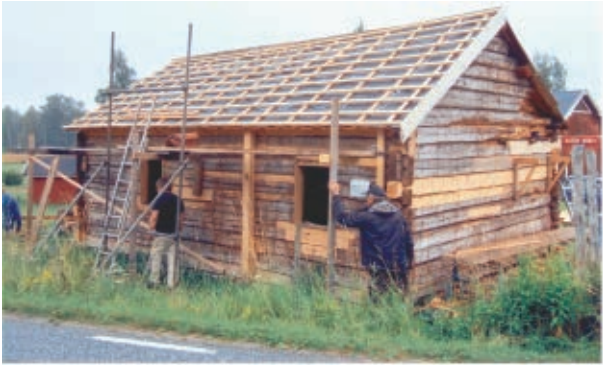
Snart är det dags att lägga på takteglet
